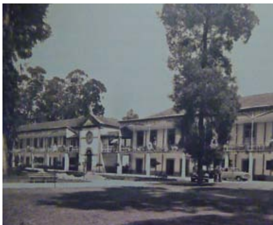
Figura 9: Sanatório-Hospital Rodrigues Semide
